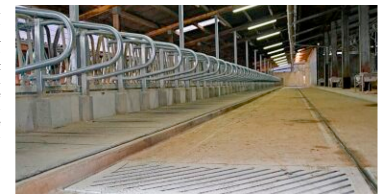
Auf dem Hof Gasswies im Klettgau konnte durch den Umbau am Fressgang viel zusätzlicher Raum geschaffen werden, sodass unter anderem abgetrennte, erhöhte, Fressplätze realisiert werden konnten.
