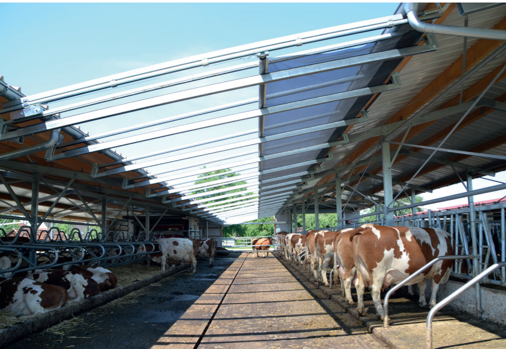
Erhöhter Fressplatz und integrierter Laufhof zwischen Liege- und Fresshalle mit Beschattungsmöglichkeit. Fotos: Prof. Dr. Barbara Benz
