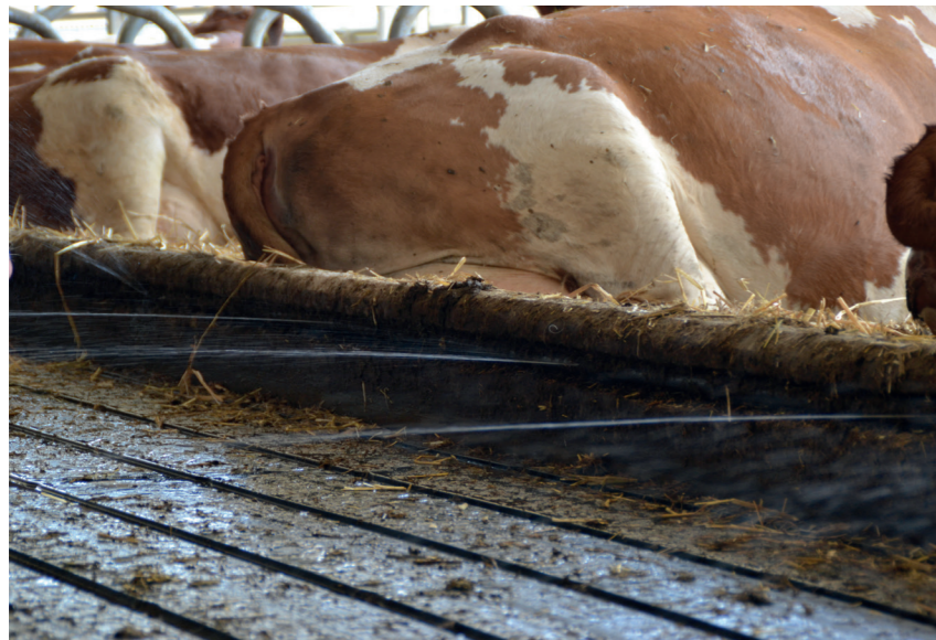
links: Der Rillenboden mit Korundeinlage. Aus dem Schlauch in der Kotkante spritzt Wasser zur Reinigung des Gummibelages und zur Verhinderung von Schmierschichten. rechts: Durch die 3 % Gefälle zur mittigen Rinne läuft der Harn ab.
