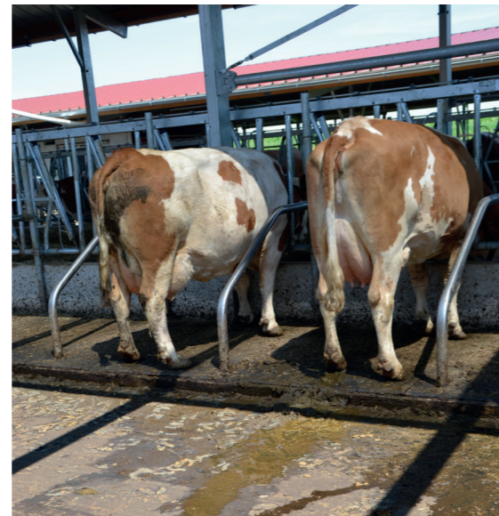
links: Der Rillenboden mit Korundeinlage. Aus dem Schlauch in der Kotkante spritzt Wasser zur Reinigung des Gummibelages und zur Verhinderung von Schmierschichten. rechts: Durch die 3 % Gefälle zur mittigen Rinne läuft der Harn ab.
