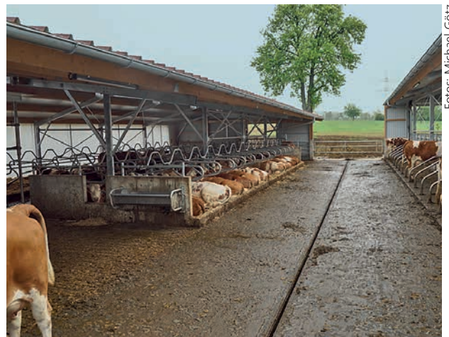
Die Laufhofflächen haben ein Gefälle von 3%. Der Harn fliesst in die Harnsammelrinne ab, die in der Führungsschiene des Schiebers ist.
