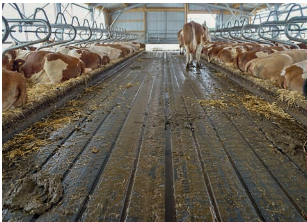
Die Zwischenflächen der Rillenmatten weisen ein leicht dachförmiges Gefälle auf, um die Gülle in die Rillen abzu-leiten.
