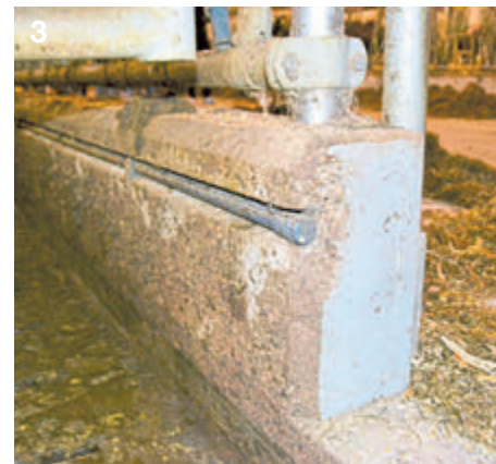
1 Der „ECOboden“ der Firma AndersBeton bietet Laufkomfort. | 2 Die Sauberkeit der Laufflächen steigt, wenn der Boden mit einer stationären Entmischungsanlage gereinigt wird. | 3 Die Laufflächen können zur Sauberhaltung zusätzlich über den Futterbarren befeuchtet werden. | Fotos: Benz
