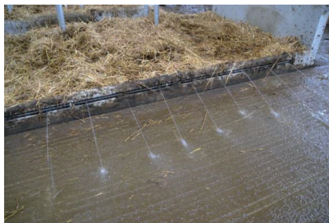
Integrierte Laufflächenbefeuchtung wirkt Schmierschichten entgegen und kann die Laufflächenhygiene unterstützen.
