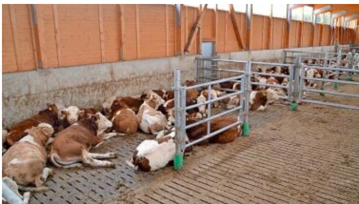
Die Tiere nutzen den Liegebereich gerne: Die Gummiauflage ist bequem und wärmegeklämt. Zudem können Flüssigkeiten durch ein Gefälle schnell ablaufen.
