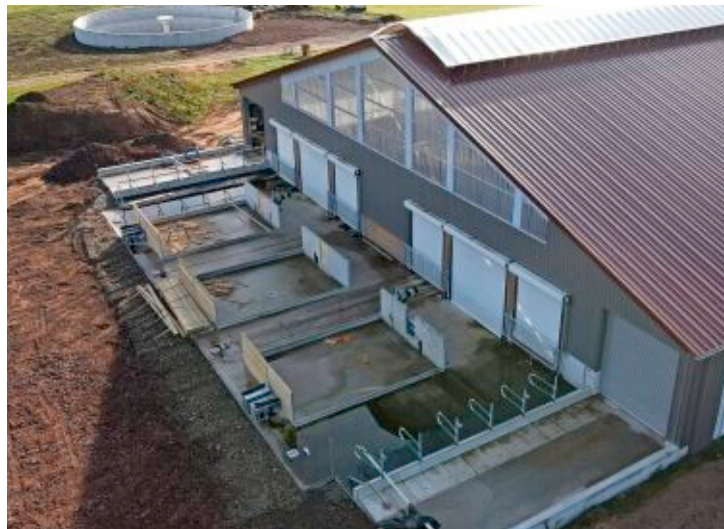
Die alternative Ausführung eines strukturierten Laufhofes: Statt Liegeboxen werden Inseln tief mit Hackschnitzeln eingestreut. Die Entmistungsachsen können auch hier fortgeführt werden. Die Überdachung der Fressplätze ist noch nicht fertiggestellt.
