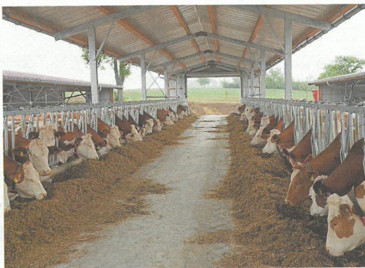
Die zentrale Futterdurchfahrt
