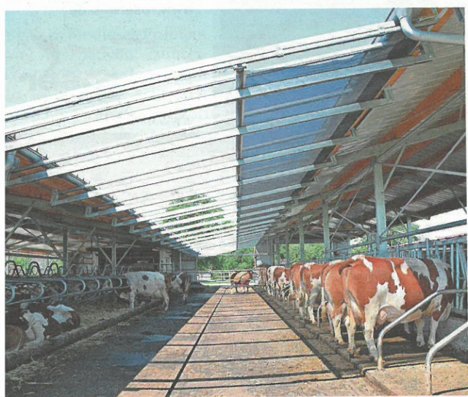
sensorgesteuerte Markisen beschatten Fressplatz und Laufhof.
