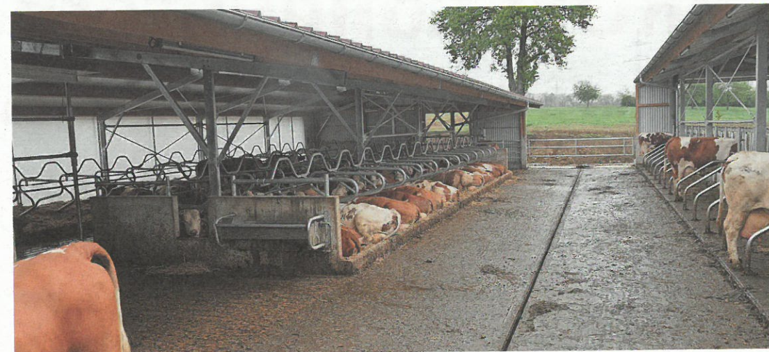
Die Laufhohflächen haben ein Gefälle von drei Prozent in Richtung Harnrinne.
